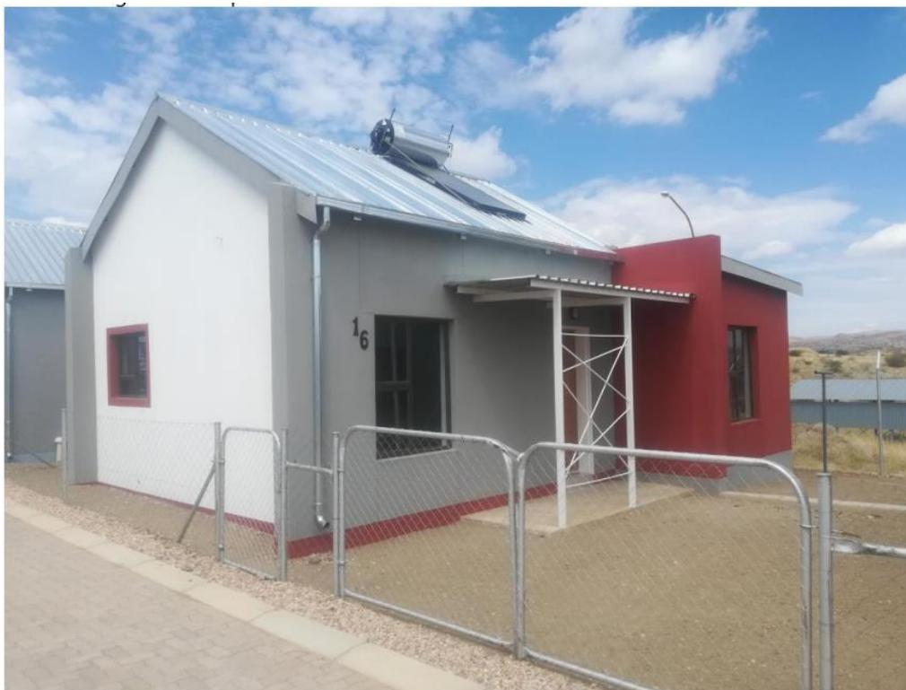
*Fig 13 : Une unité achevée avec tous les équipements, y compris le chauffe-eau solaire.*
